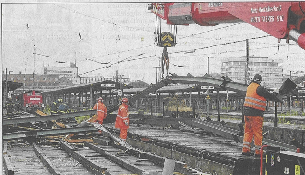
Schweres Gerät im Einsatz: Mit einem Kran wurden die abgerissenen Dachteile von den Schienen gehoben.
